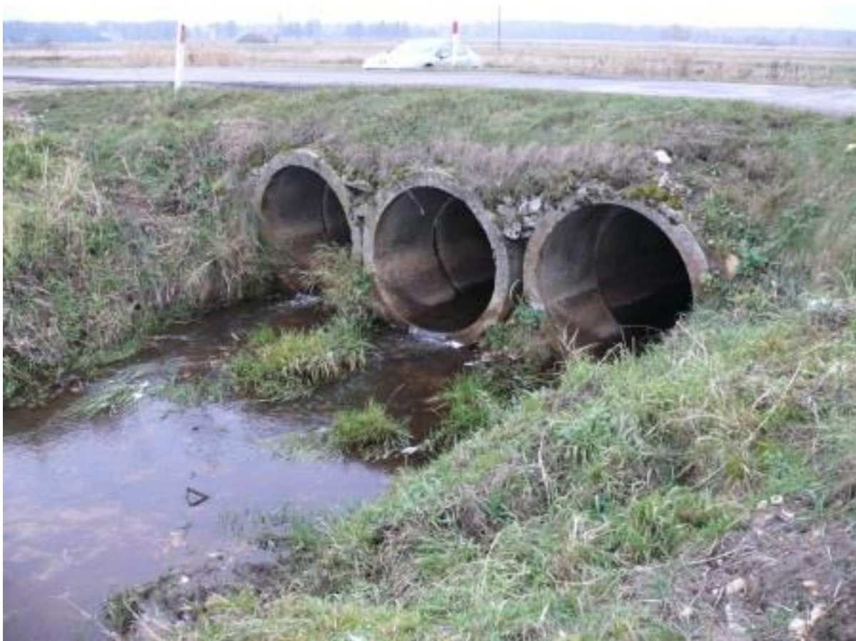
Fot. Nr.4. Widok przepustu od strony WD.
