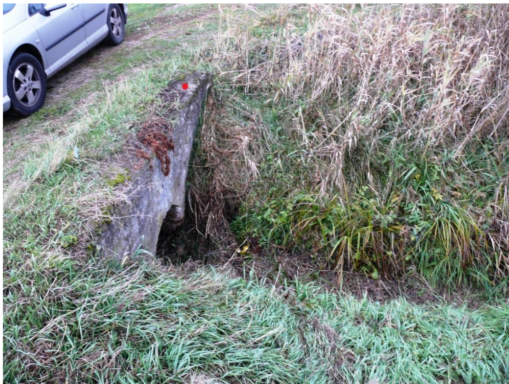
Fot. Umieszczenie Rp ( H=228,97 m n.p.p.)
