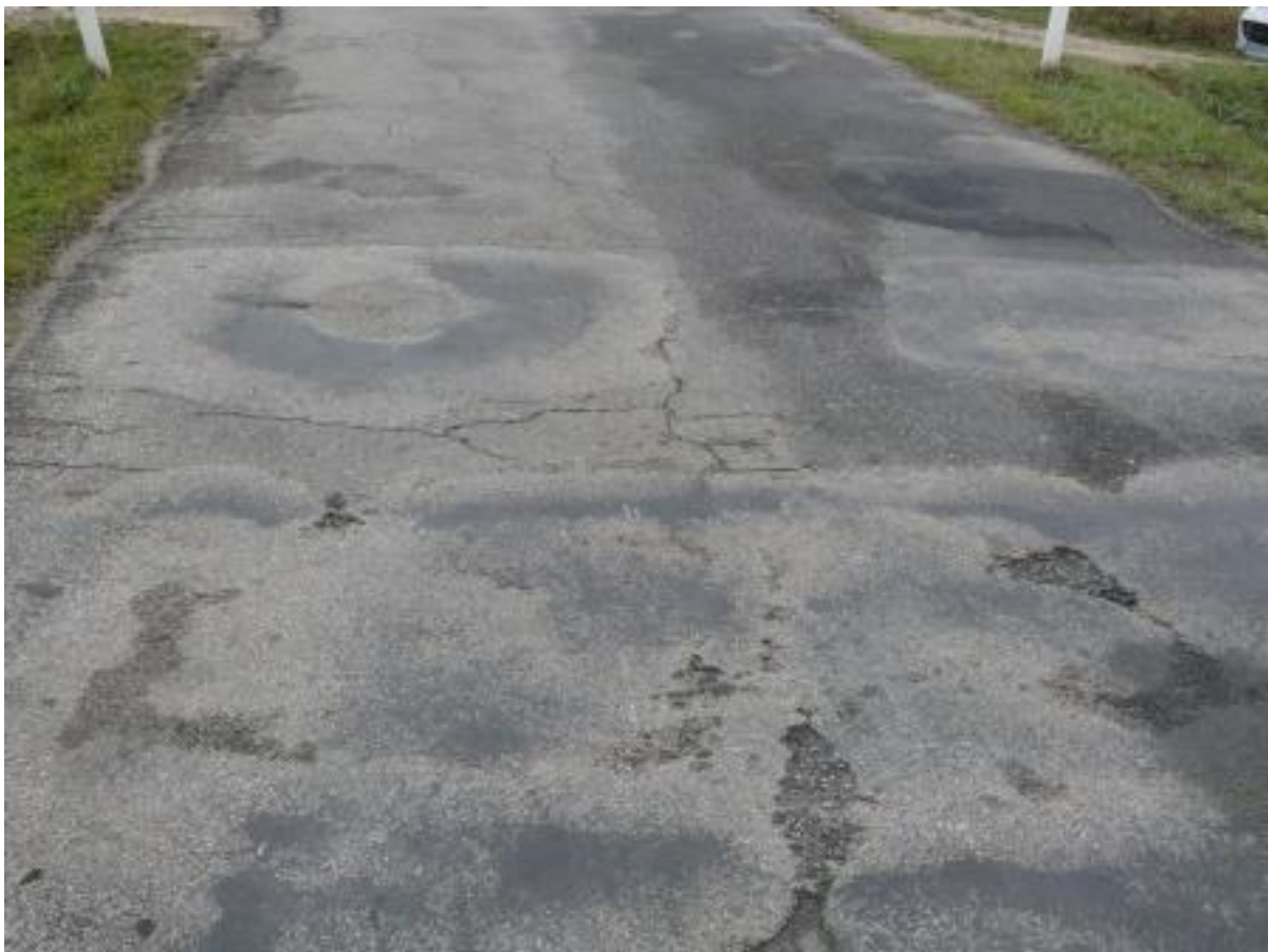
Fot. Nr. 3. Widok jezdni nad przepustem .
