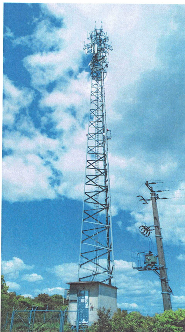
Zdjęcie 1 Badany obiekt
