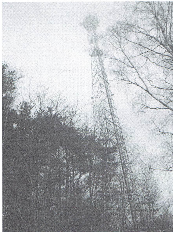
Zał. nr 1: Widok ogólny instalacji radiokomunikacyjnej.
